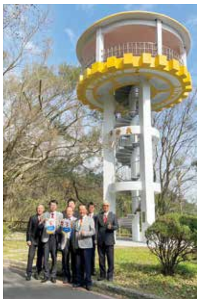
石門扶輪亭修繕後的全貌
