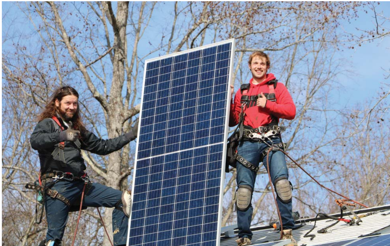
工人們在北卡羅來納州希爾斯伯勒 (Hillsborough) 一處仁人家園住宅的屋頂上安裝太陽能板。
