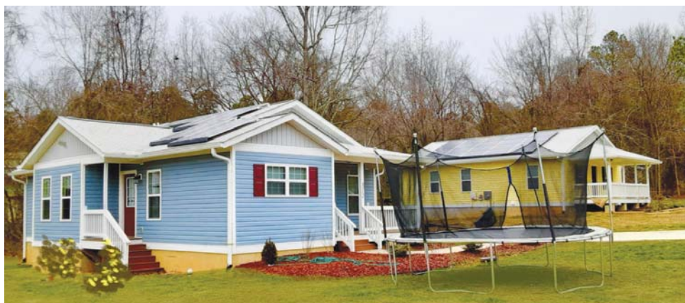
左圖：仁人家園在北卡羅來納州橘郡 (Orange County) 建造的帶有屋頂太陽能電池板的房屋。
