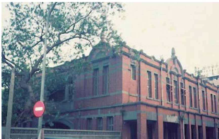
台北更生院拆除前——林小昇於 1994 年拍攝
