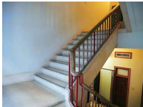
勸業銀行台北支店樓梯
