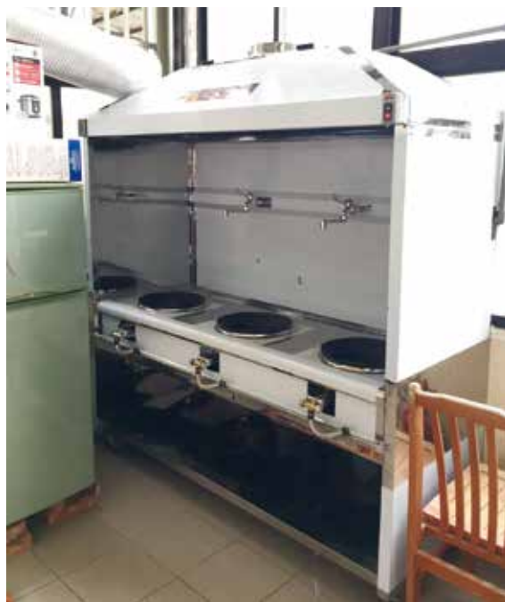
花園部落修繕工程落成啟用。廚房一角
