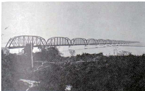
下淡水溪橋梁
